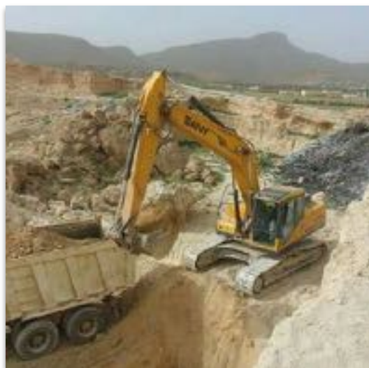
Luc der fik kørekort til lastbil og kran og som nu har periodisk arbejde i grusgrave, ved minedrift og anlægsarbejder.
